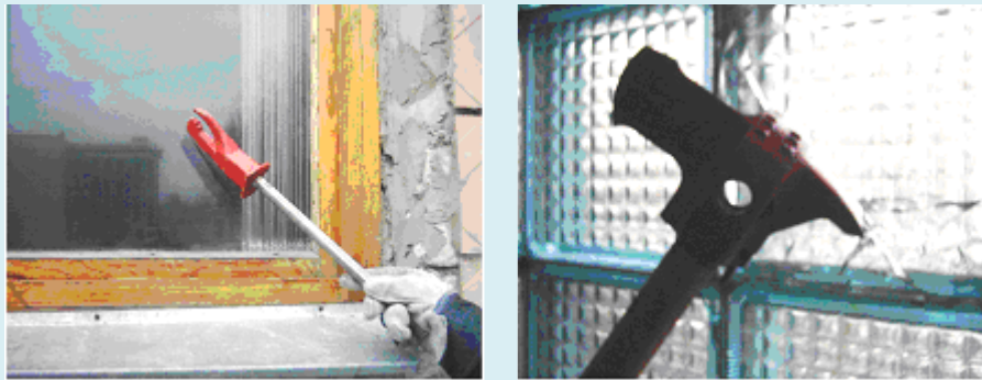
Рис. 3.20. Виготовлення отворів за допомогою інструмента ІРАР
